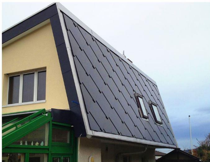
Figur 16: Sun Stylesolartak integrert i tak med nesten 90 ° helningsvinkel.
