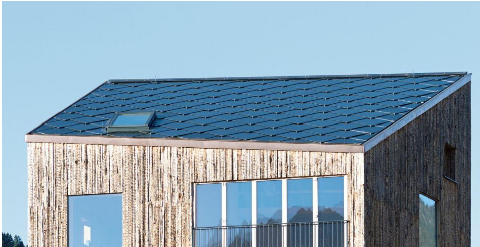
Figur 15: Sun Stylesoltak installert på et pulttak med takvindu
